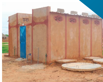
ONG Eau vive : bloc de latrines et douches publiques finalisés
