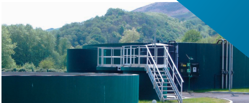
Station d'épuration d'Itxassou du Syndicat URA
