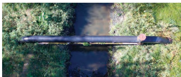
Canalisation de transport d'eau brute
