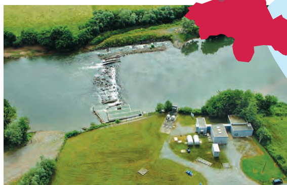
Les travaux effectués sur le seuil d'Haitze
